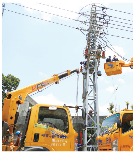
海口供电局城市配网管理中心工作人员对10千伏线路进行消缺。通讯员 杨永光 摄
