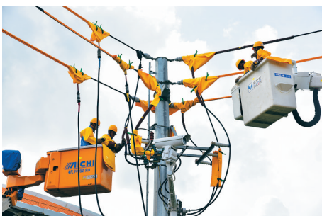
电力工人带电作业。刘昌 摄
