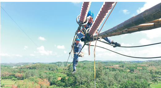
电力工人在30米高的输电线上更换绝缘子。
