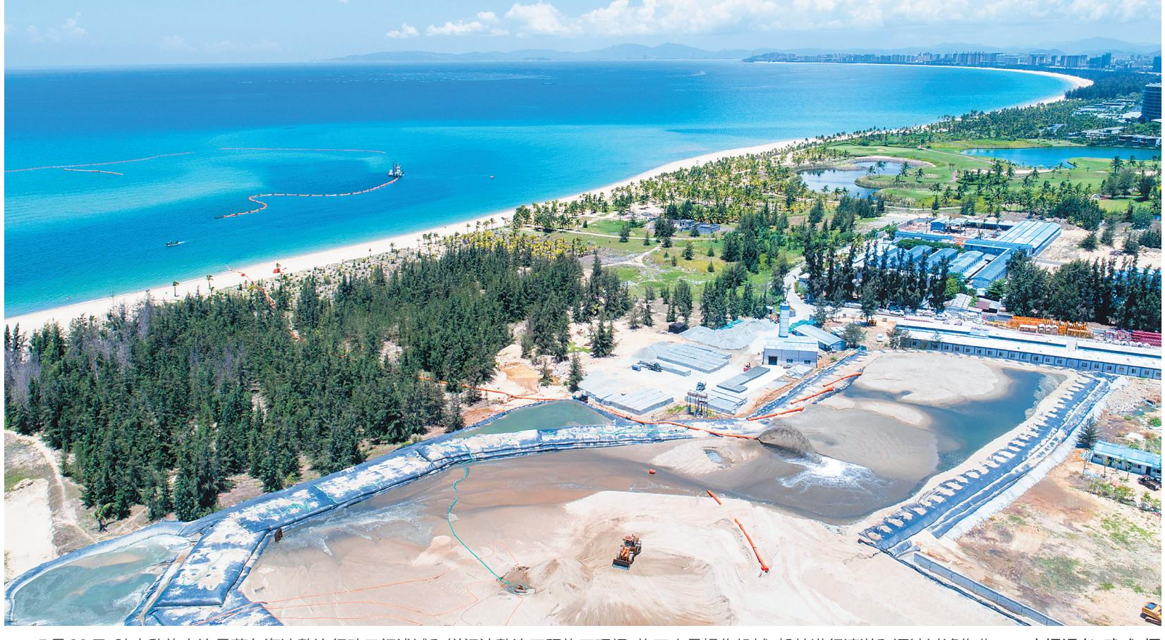
5月23日,陵水黎族自治县蓝色海湾整治行动口门浅滩和拦门沙整治工程施工现场,施工人员操作机械、船舶进行清淤和沉淀过滤作业。本报记者 武威 摄
