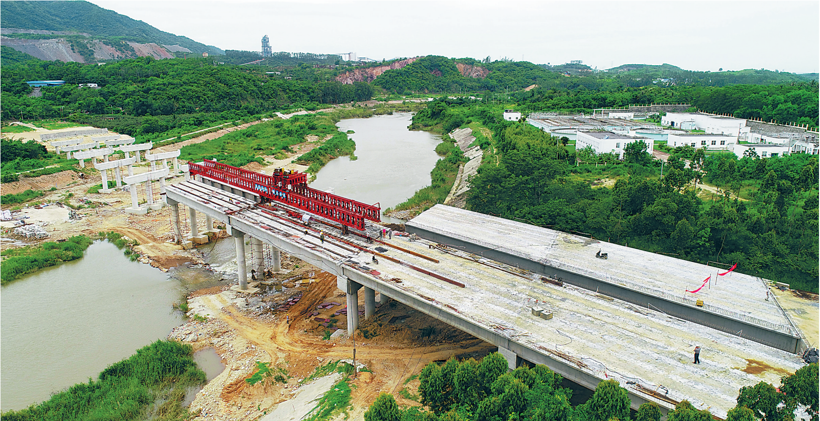
6月13日,石碌河第三大桥建设项目正在加紧施工,多名工人在桥面上操作架桥机作业。 本报记者 苏晓杰 通讯员 杨耀科 摄
