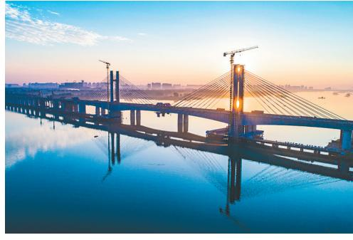
8月20日,由中铁十一局集团承建的蒙华铁路汉江特大桥斜拉索挂索全部完成。蒙华铁路汉江特大桥位于湖北省襄阳市区上游约3公里的汉江上,总长5242米。该桥江面共18座桥墩,位于江面上的主桥最大跨径248米。新华社发
