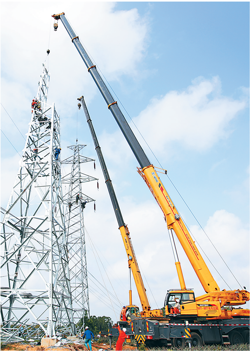
南方电网海南琼海供电局施工人员正对110千伏福田输变电线路工程进行组塔安装。
