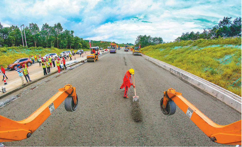
2017年7月，琼乐高速B5标段，施工人员在铺设路面。 本报记者 陈元才 摄
