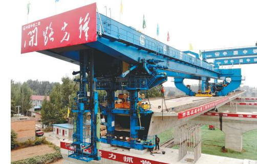
9月27日,中铁二局的施工人员使用大型机械在郑(州)济(南)高速铁路(郑濮段)站前工程V1标施工现场架设40米简支箱梁(无人机拍摄)。
