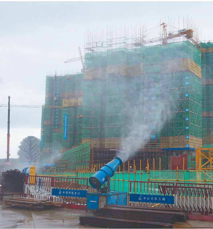
在三亚月川棚户区改造项目施工现场,工地智能化管理系统控制雾炮喷淋、围墙喷淋系统进行降尘作业。 武昊 摄
