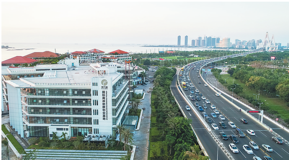
俯瞰海口复兴城国际离岸创新创业基地。目前，普华永道等一批知名外企已入驻。 本报记者 袁琛 摄
