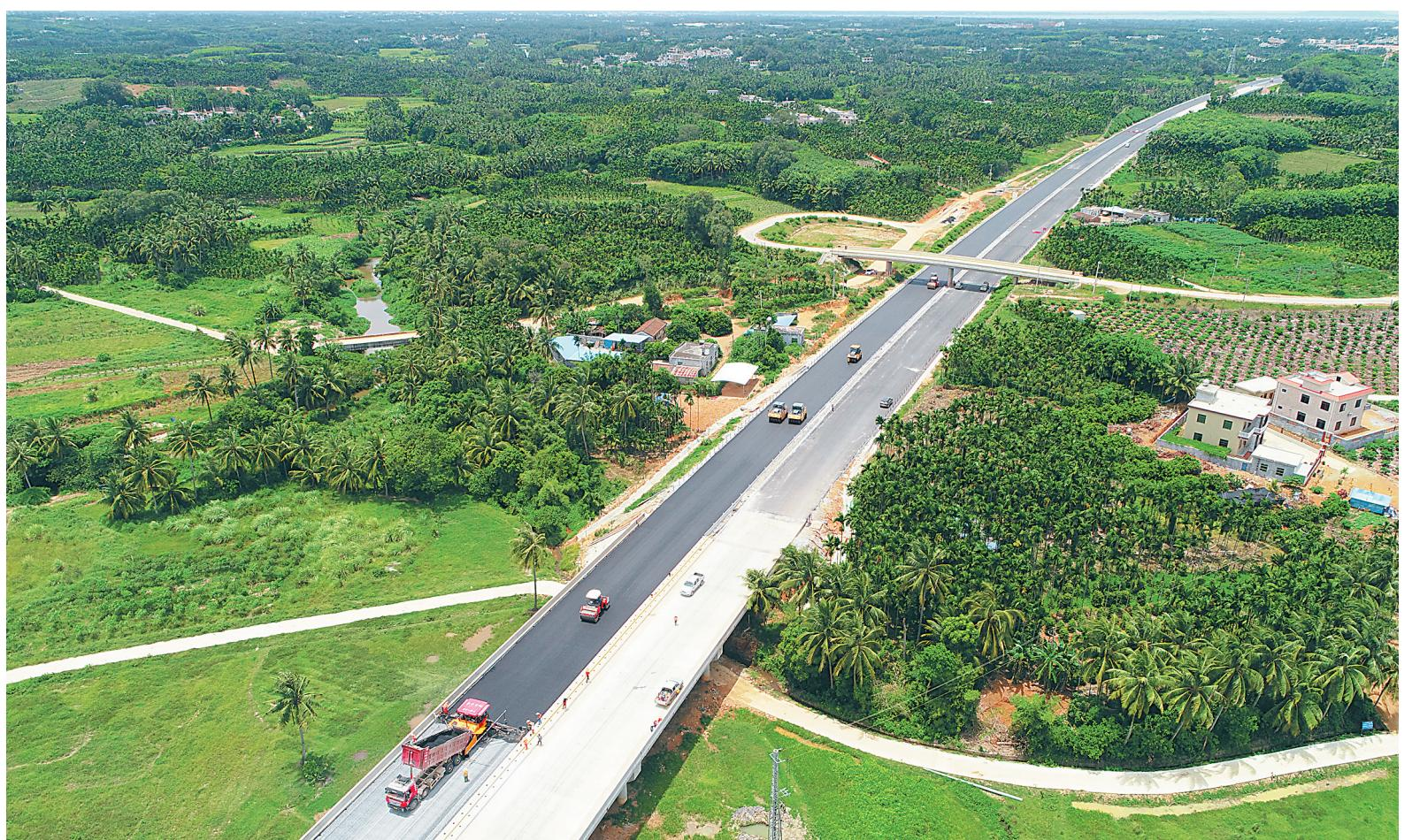
7月6日，俯瞰万洋高速万宁段，几台压路机来回穿梭，施工车辆在进行清扫沥青中层面、洒粘层油和上层面沥青摊铺等工作。目前，主干道路面基本完成，其他配套设施也正在紧锣密鼓施工中。
