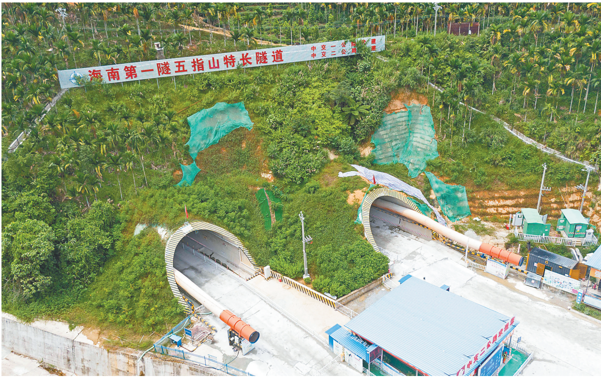
俯瞰五指山特长隧道洞口处，洞口边坡目前已进行覆绿。海报集团全媒体中心记者 汪承贤 摄
