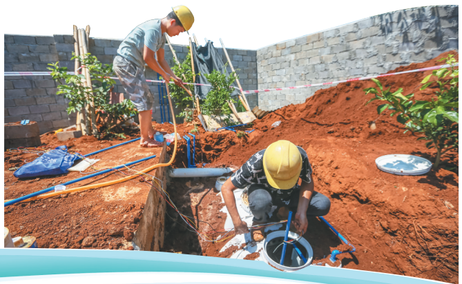
海口市秀英区石山镇道育村,工人正在安装生活污水处理罐。本版图片均由本报记者 袁琛 摄
