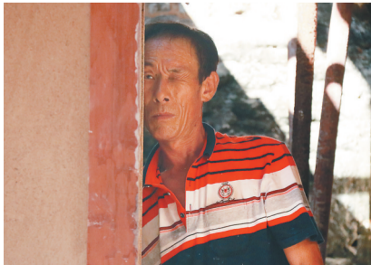
水泥师傅临墙比对以确定水平线。
