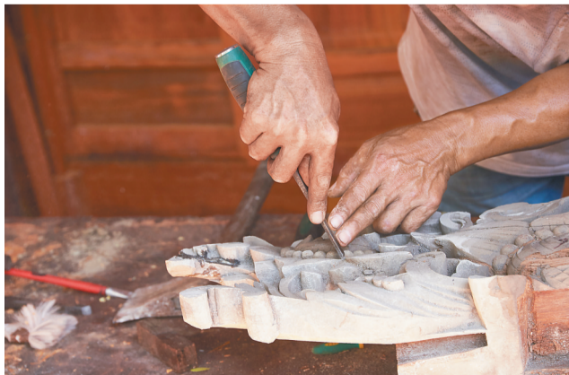
卫师傅用刮刀进行古建筑的节点处理，多年的工作令他的左右手上形成明显色差。
