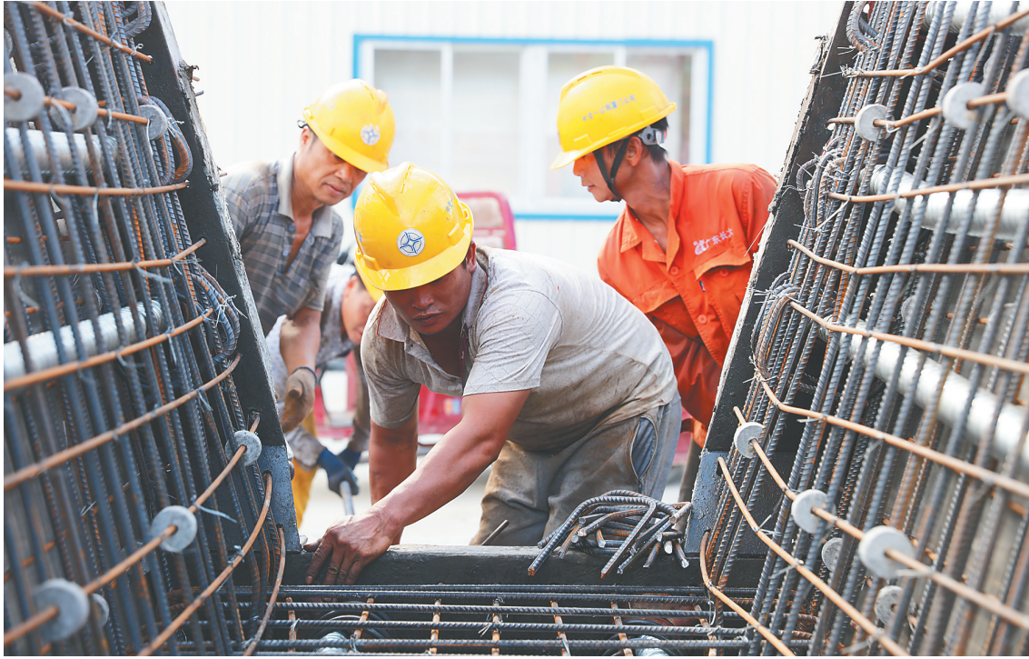
日前，儋州至白沙高速公路项目阜龙钢筋集中加工厂，工人正在加工钢筋。海报集团全媒体中心记者 韦茂金 摄
