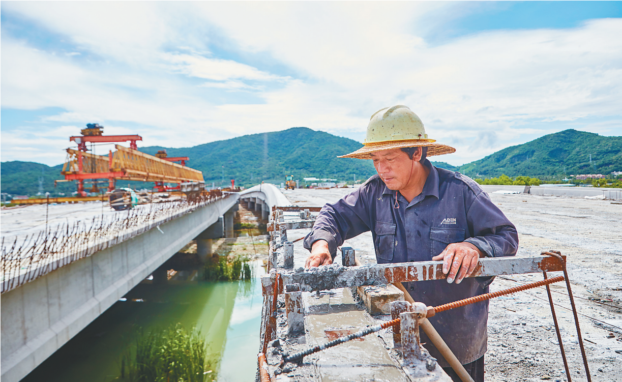
9月11日，亚龙湾第二通道（一期）工程，工人们在烈日下作业。图为工人正在搭建大茅河桥两侧护栏。 见习记者 封烁 摄
