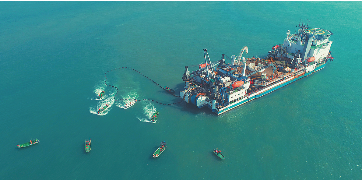
2019年2月9日，海南联网二回工程首根海底电缆登陆迈迈。图为绑扎好浮体的海缆从船尾缓缓释放至海面。
