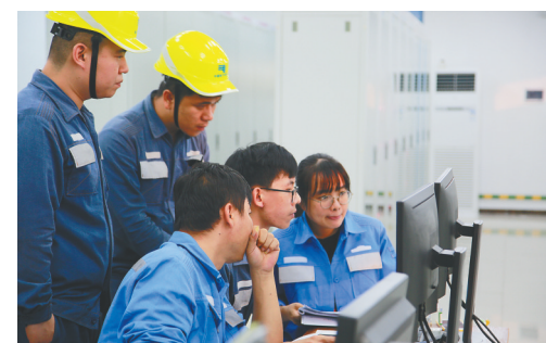
琼海供电局工作人员对琼海110千伏乐城变电站的作业风险进行严格管控,确保变电站顺利投运。卢传隆 摄
