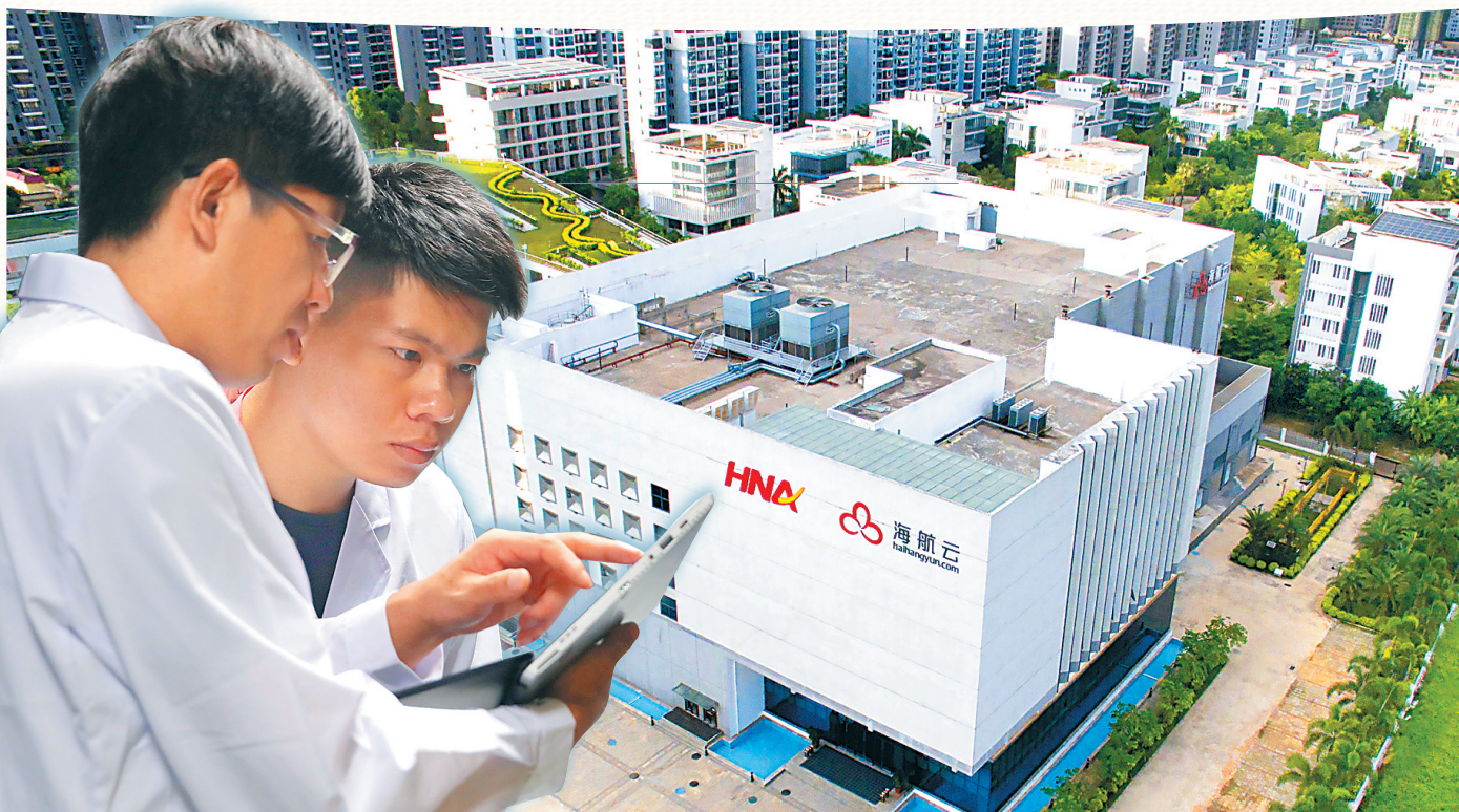
易航科技南方数据中心运维工程师在进行日常工作。位于澄迈老城开发区的易航科技南方数据中心。易航科技供图
