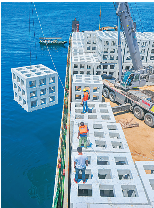
文昌冯家湾海洋牧场建设项目投放人工渔礁。 海南日报记者 袁琛 摄
