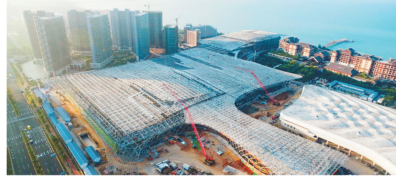
11月21日,海南国际会展中心二期工程有序推进。 本报记者 陈元才 摄
