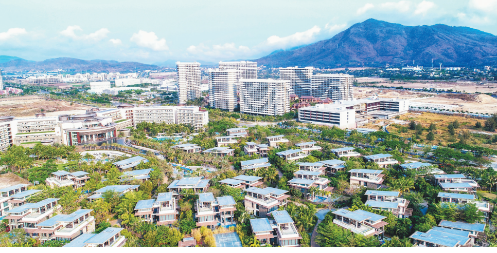
俯瞰建设中的三亚崖州湾科技城。 本报记者 武威 摄
