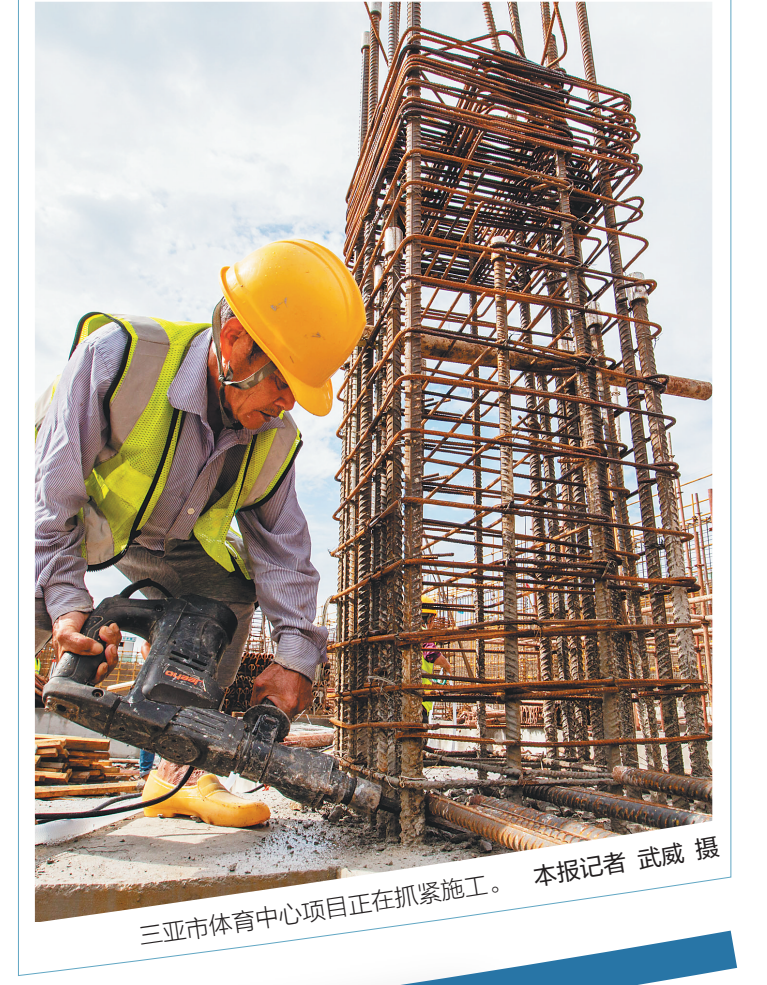
三亚市体育中心项目正在抓紧施工。 本报记者 武威 摄
