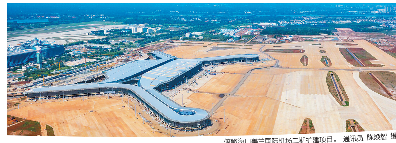
俯瞰海口美兰国际机场二期扩建项目。 通讯员 陈焕智 摄
