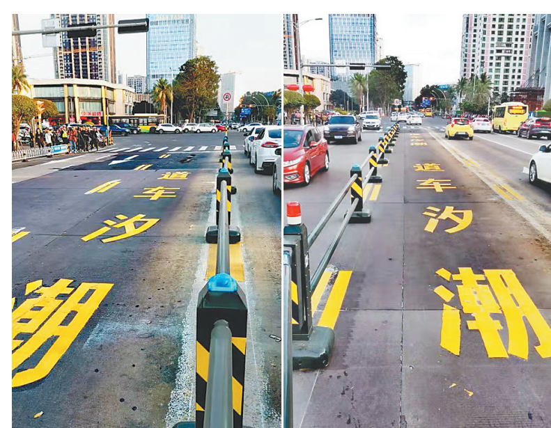
在海口市滨海大道与玉兰路交叉口，交警通过手机遥控移动护栏，实现潮汐车道隔离切换。 本报记者 邓海宁 摄
