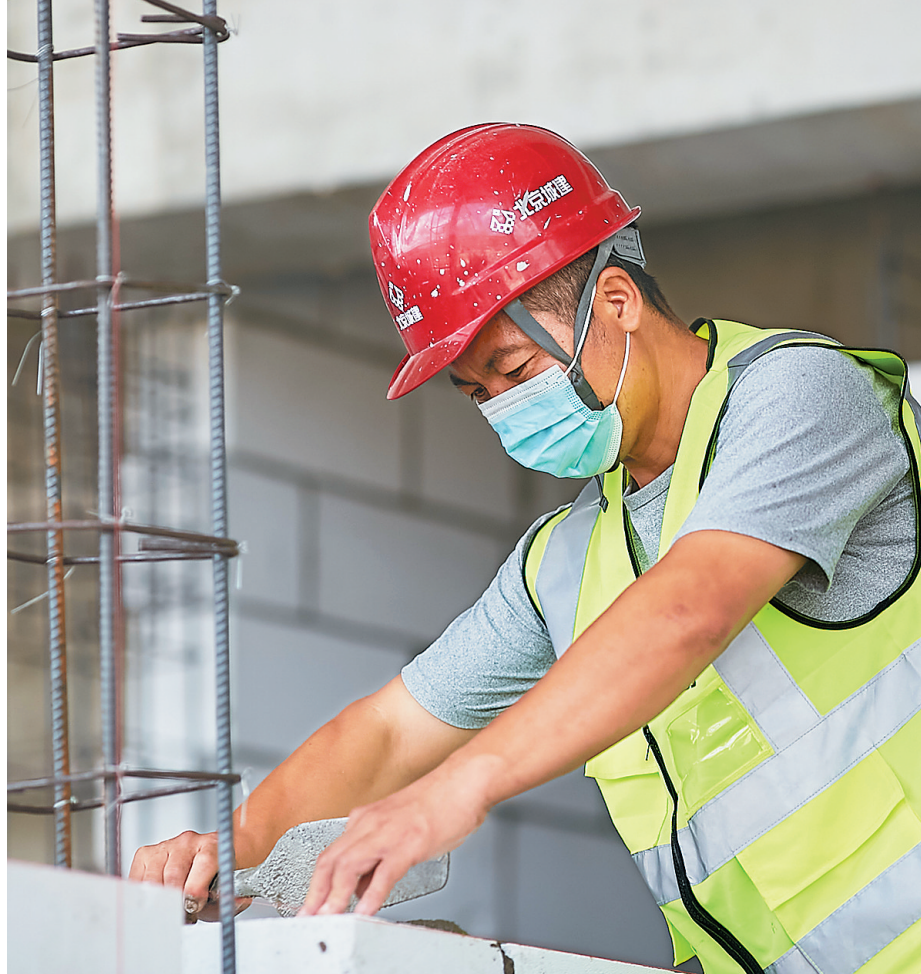
3月21日，三亚国际体育产业园建筑工地内，瓦砖工符启桥正为看台内层结构梁柱砌砖墙。来自重庆的他已有25年的瓦砖工经验，从三亚国际体育产业园施工开始，他就一直参与修建工作。摘下口罩后，他露出了淳朴的笑容。 本报记者 封烁 摄
