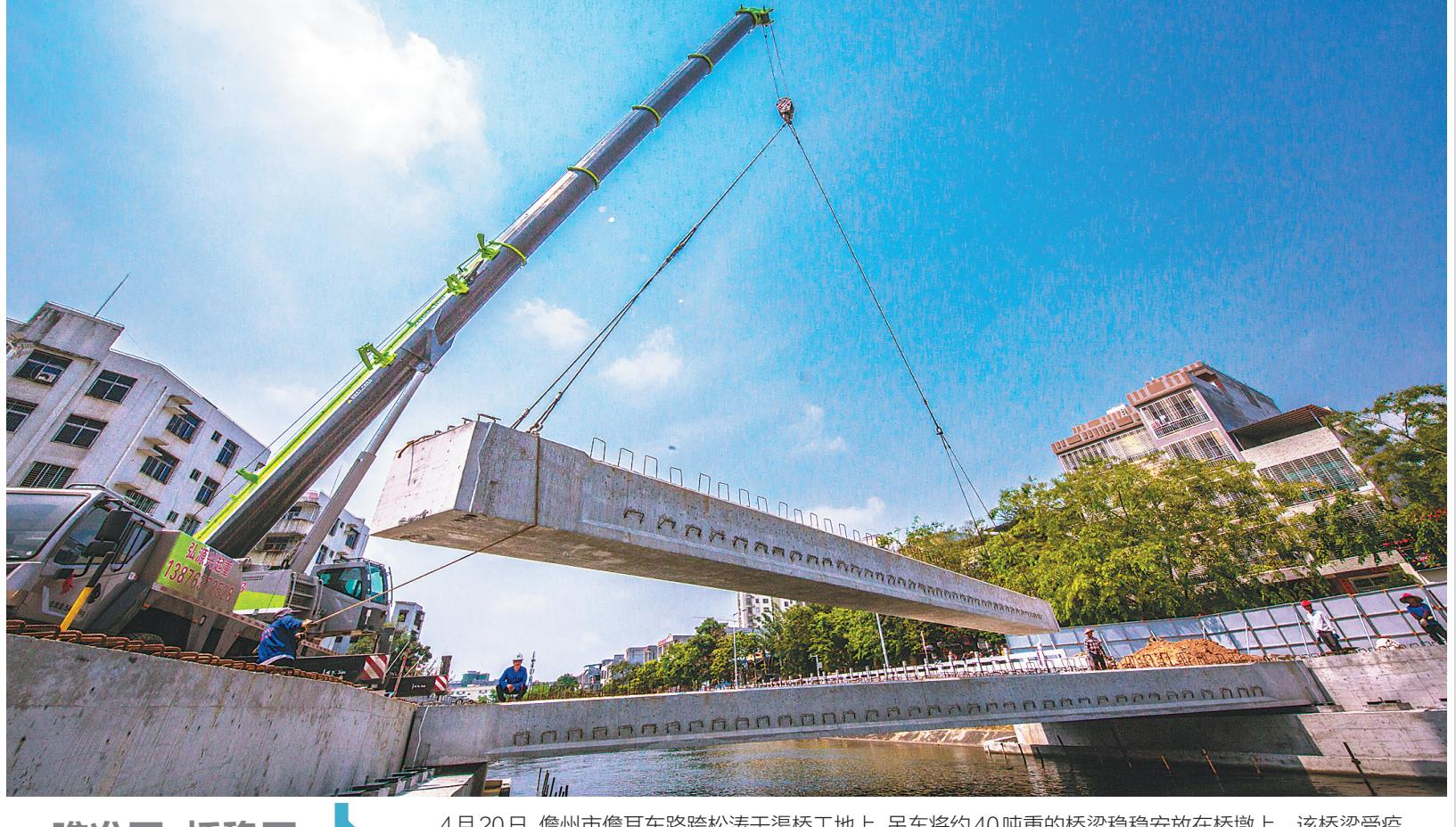
4月20日,儋州市儋耳东路跨松涛干渠桥工地上,吊车将约40吨重的桥梁稳稳安放在桥墩上。该桥梁受疫情影响停工,复工复产后承建方争分夺秒抢时间,桥梁建成后将极大地方便群众出行。特约记者 吴文生 摄
