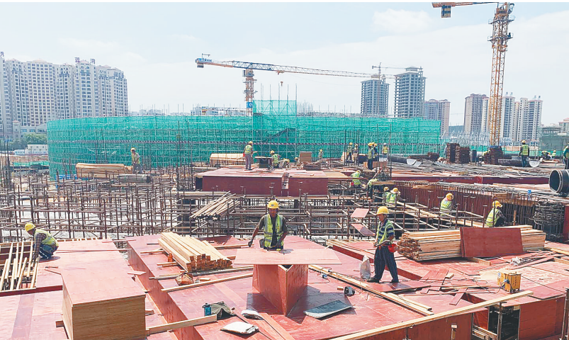
4月27日上午,在东方文化广场项目施工现场,工人正在进行钢筋绑扎作业。
