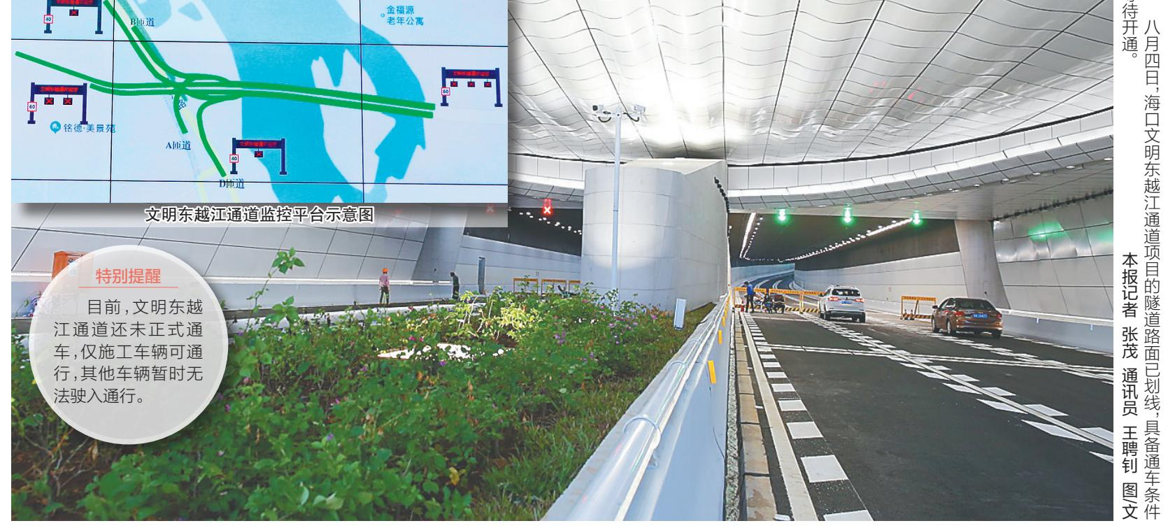
据了解，文明东越江通道顶部的防火板和侧墙的搪瓷钢板，均采用新型材料，不仅看上去简洁大方，而且也便于日常维护。
