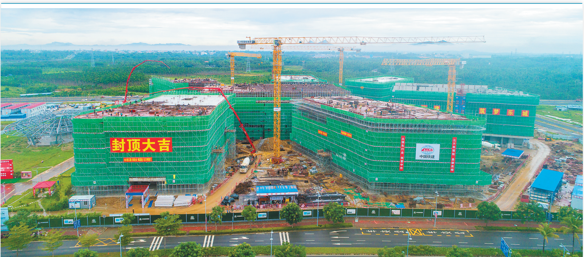
博鳌研究型医院项目主体结构全面封顶
