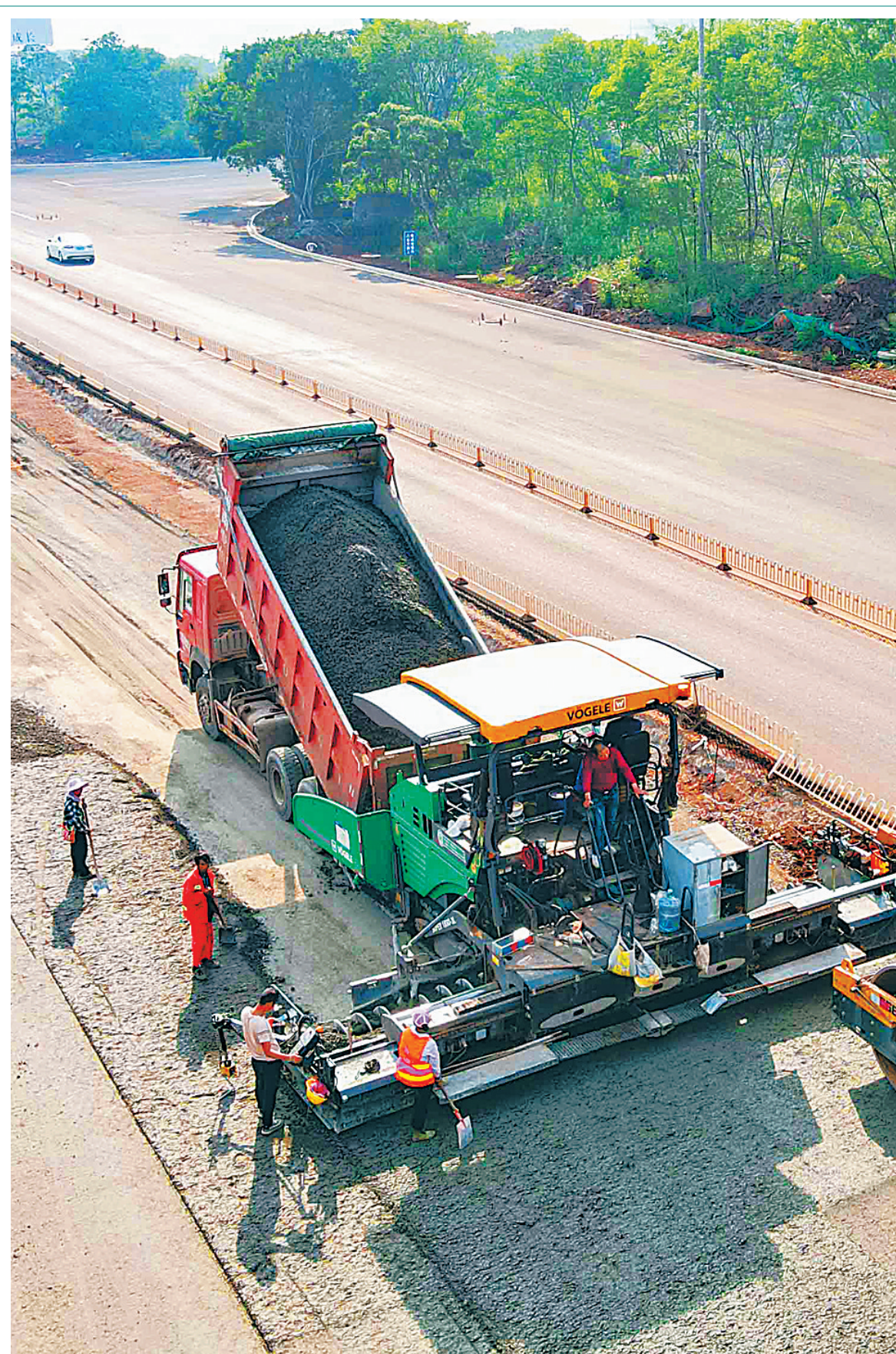
洋浦疏港大道二期 加快建设
