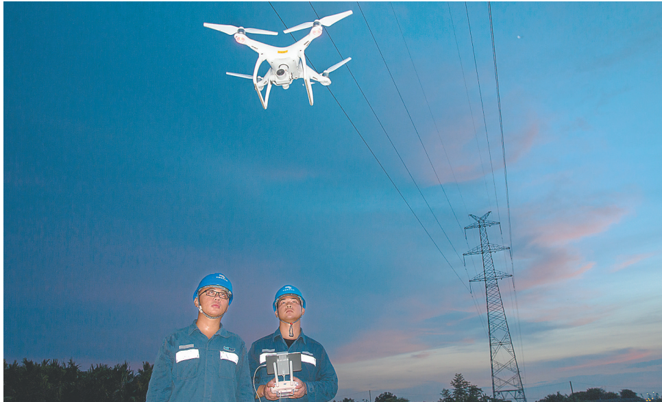
海南电网公司利用无人机对线路进行巡检。 西海 摄
