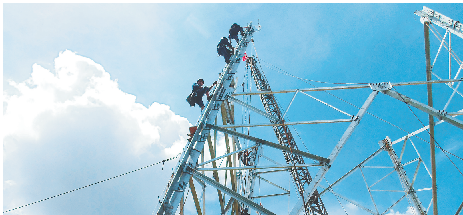
烈日下,南方电网海南电网公司工作人员在工作。 许振音 摄
