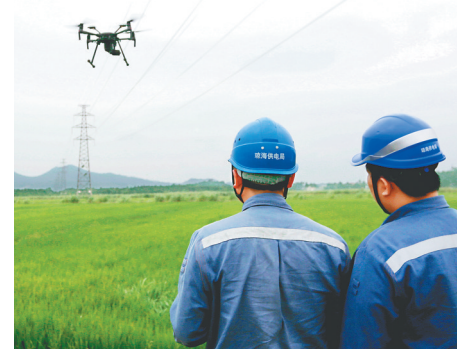
南方电网海南琼海供电局工作人员在使用无人机巡线。 卢传隆 摄
