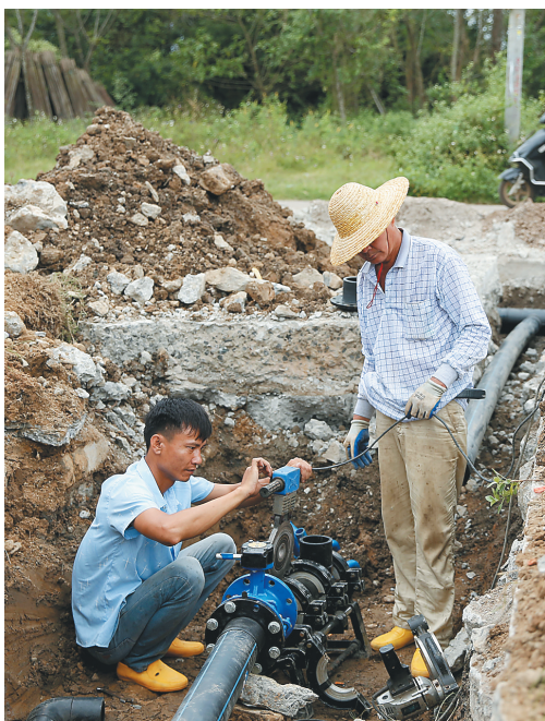
工人正在澄迈县永发镇卜罗村进行污水地下管网施工，该村正在铺设污水管道17000多米。
