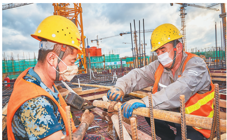
2月14日，第六届三亚亚洲沙滩运动会亚沙村A区建筑工地内，工人在进行模板安装加固工作。
