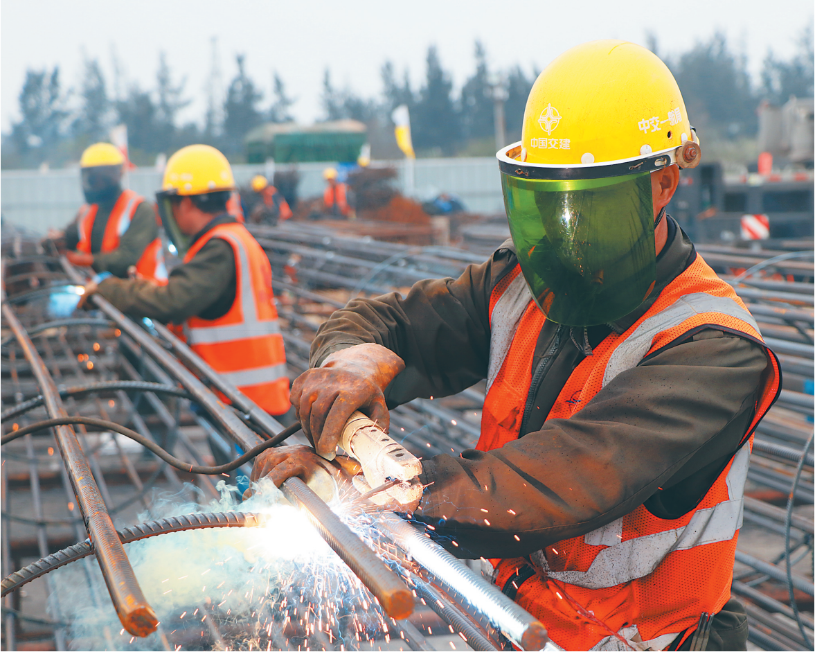
1月10日下午，在海口江东新区高品质饮用水水厂项目工地，工人在一起焊接钢筋笼。 通讯员 郝尉淞 摄
