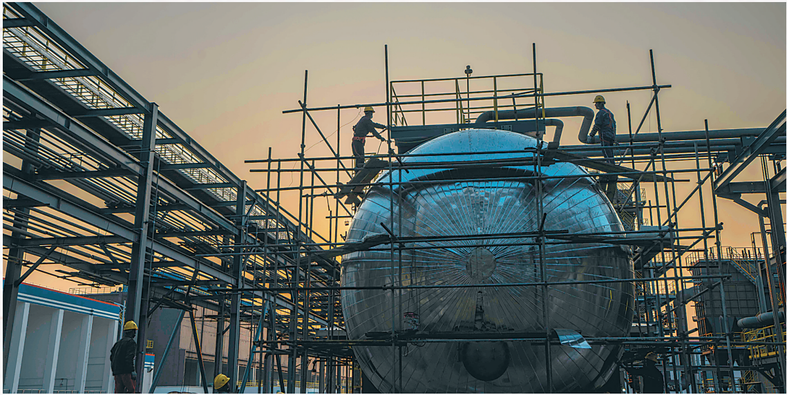
2020年9月，项目空分空压装置加快制作安装。
