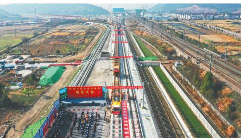
2月1日在浙江临海的杭绍台铁路建设工现场,首对500米长钢轨被安全平稳地铺设到无砟轨道道床上,标志着杭绍台铁路工程转入全线铺轨阶段。杭绍台铁路是我国首条民营资本控股的高速铁路项目,计划在2021年建成通车。图为铺轨施工现场。
