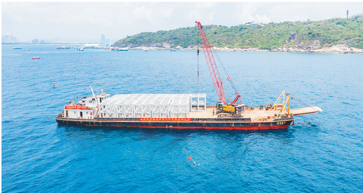
4月8日，在三亚蜈支洲岛海域，工作人员正操控吊机将人工鱼礁放入海底。
