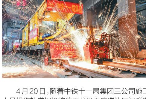
4月20日，随着中铁十一局集团三公司施工人员操作轨道焊机将位于龙潭至磨碟沙区间隧道内的最后一个钢轨接头焊接完成，全长58.3公里的广州地铁18号线首通段(万顷沙至冼村)全线长轨贯通。广州地铁18号线连接广州市中心城区与南沙自贸区，是粤港澳大湾区首条160公里时速的地铁线路。图为轨道焊机在焊接最后一个钢轨接头。
