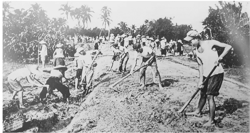
海榆中线修路大军的劳动场面。 本报记者 陈奕霖 翻拍
