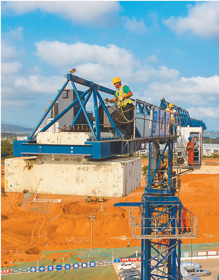
在陵水黎安国际教育创新试验区项目建设现场，工人检修塔吊。
