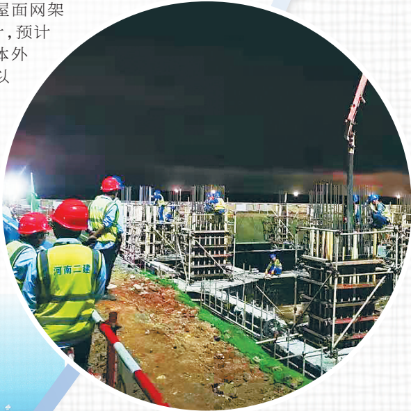
图为洋浦天然气热电联产项目1号机组主厂房进行基础混凝土浇筑。受访单位供图
