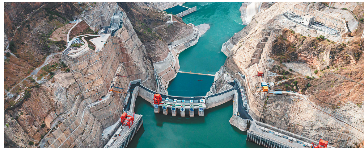
空中俯瞰乌东德水电站全景。新华社发
