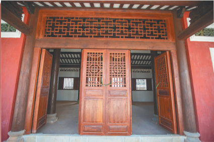
修复后的鼓楼，木构件部位刷上了油漆进行防腐。 海南日报记者 袁琛 摄
