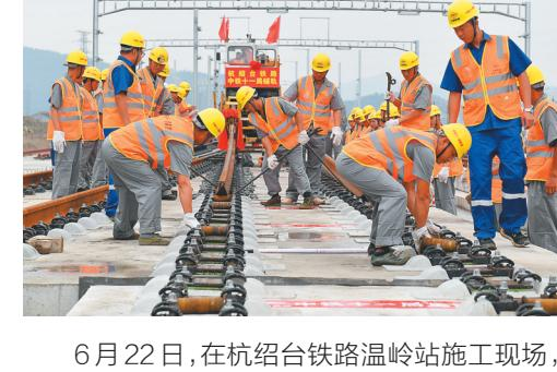
6月22日，在杭绍台铁路温岭站施工现场，随着最后一根钢轨平稳在无砟道床上铺设到位，我国首条民营控股高铁杭绍台铁路全线铺轨贯通。杭绍台铁路连接浙江杭州、绍兴和台州三地，线路设计时速350公里。
