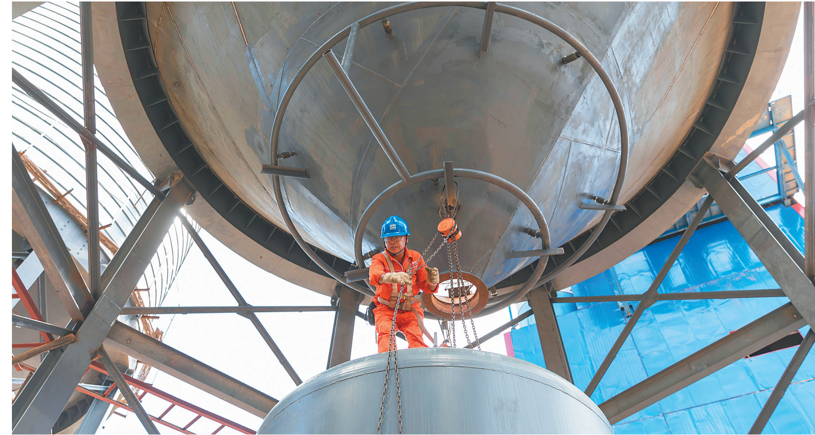
6月26日,在迈湾水利枢纽工程拌合系统施工现场,工人安装混凝土储存设备。迈湾水利枢纽工程是国家重大水利工程项目之一,建成后将为周边市县用水提供保障,并使海口江东新区防洪标准达到百年一遇。
