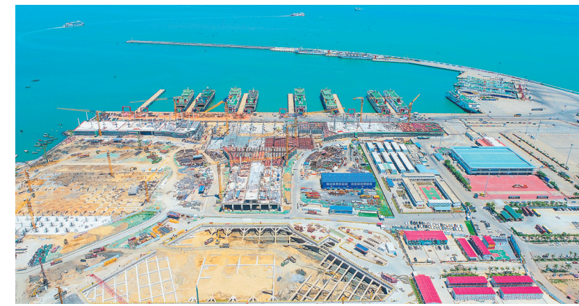
7月15日，海口新海滨集装箱码头客运综合枢纽站工程项目现场，一派繁忙的施工场景。目前，该项目中心区地下室已封顶。该项目建设内容包括一座T字形客运枢纽站、汽车待渡场、安全查验通道室外配套设施等。 本报记者 张茂 摄
