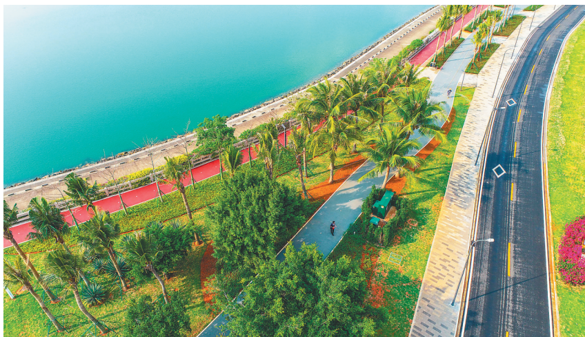
俯瞰海口湾畅通工程，该工程岸线全长约19.6公里，沿岸各区段因地制宜、各有特色，坚持公共开放，彰显生态底色，实现还海、还岸、还景于民。 本报记者 张茂 摄
