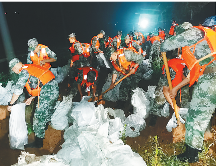
7月21日凌晨，在洛阳伊川县伊河拦水坝，中部战区第83集团军某工程防化旅官兵装沙袋封堵决口。 新华社发（张晓昆 摄）
