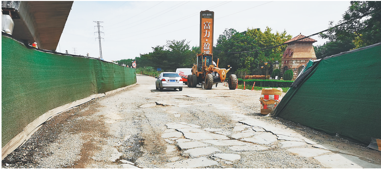
G15沈海高速海口段项目粤海大道段导改路，不仅道路狭窄，而且路面满是龟裂纹。本报记者 张期望 摄
