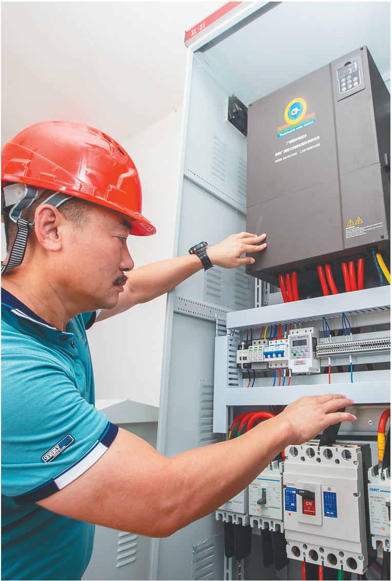
三亚市崖州区大坎坡村光电控水项目的中控智能系统。 本组图片均由本报记者 袁琛 摄
