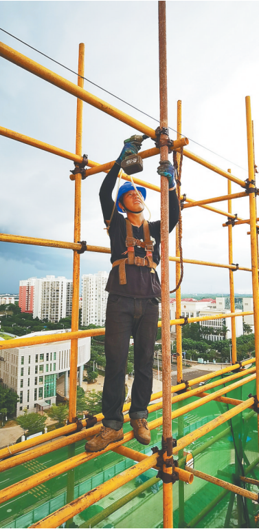
在洋浦国际航运大厦项目建设工地,工人正在安装脚手架。 本版图片均由本报记者 林书喜 摄
